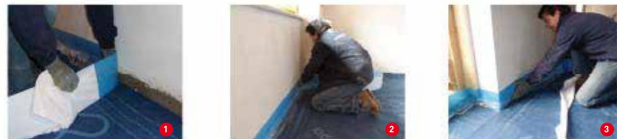
Nel caso di sistemi radianti industriali, il nastro perimetrale sarà da 8 x 250 mm anziché 8 x 150 mm.
