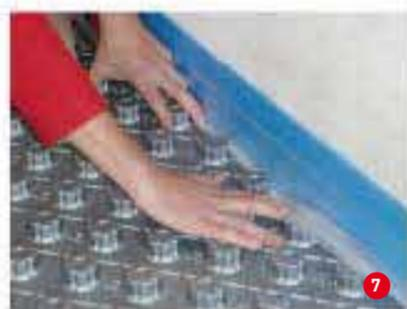
Il pannello deve essere tagliato in modo da essere in perfetta aderenza con la striscia perimetrale; il foglio di nylon del nastro perimetrale deve essere sollevato e successivamente fissato sulla parte superiore della lastra posata, in modo da evitare eventuali infiltrazioni del getto cementizio (foto 7).
