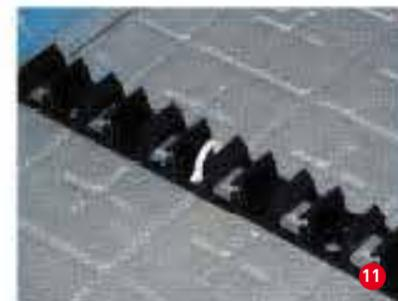
Nel sistema HSTRONG INDUSTRY la posa dell'isolante liscio (estruso) a spigolo vivo avviene come per i sistemi civili precedentemente elencati; sopra il pannello viene steso un foglio di polietilene da 0,2 mm a protezione della lastra (sormonto 250 mm.). In alternativa al sistema con fissaggio tramite tacker, il tubo può essere ancorato su una scina (foto 11) che viene posata sopra l'isolante a distanza di un metro circa l'una dall'altra.
